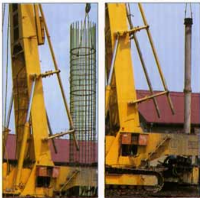
● 鉄筋の建込み
