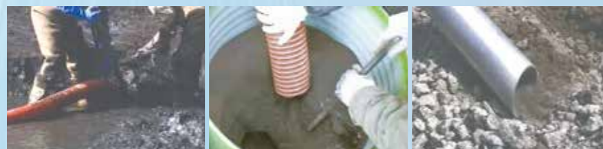
▲しゅんせつ泥土吸引
